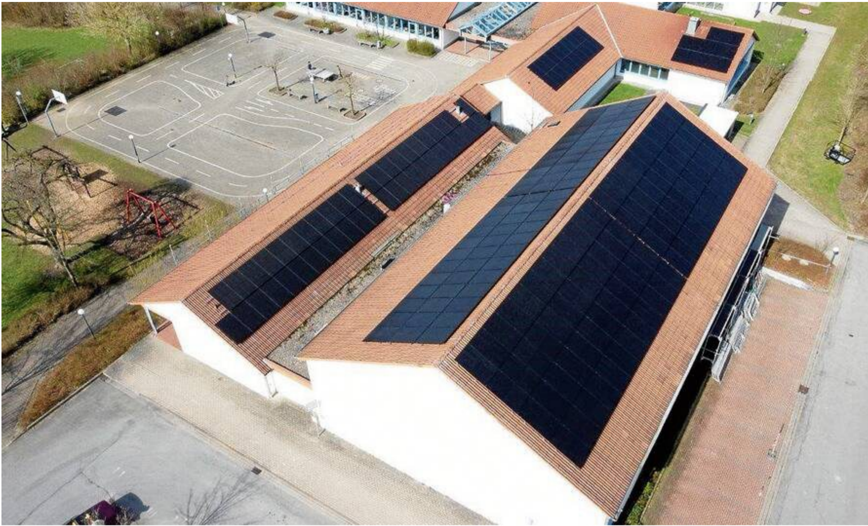
Auf dem Dach der Grundschule Rischenau wurde eine 100-kWp-Anlage installiert – die nunmehr fünfte Anlage der lokalen Energiegenossenschaft Engeno Pyrmont-Lügde.
