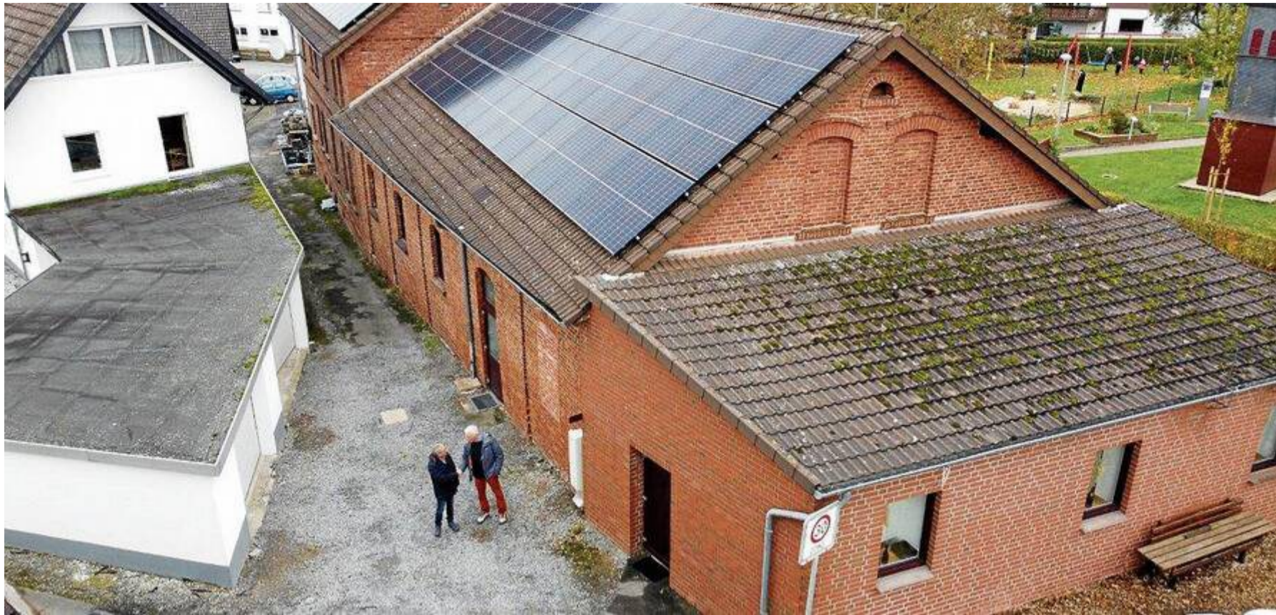
Die PV-Anlage auf dem Dach des Sabbenhausener Dorfgemeinschaftshauses.
