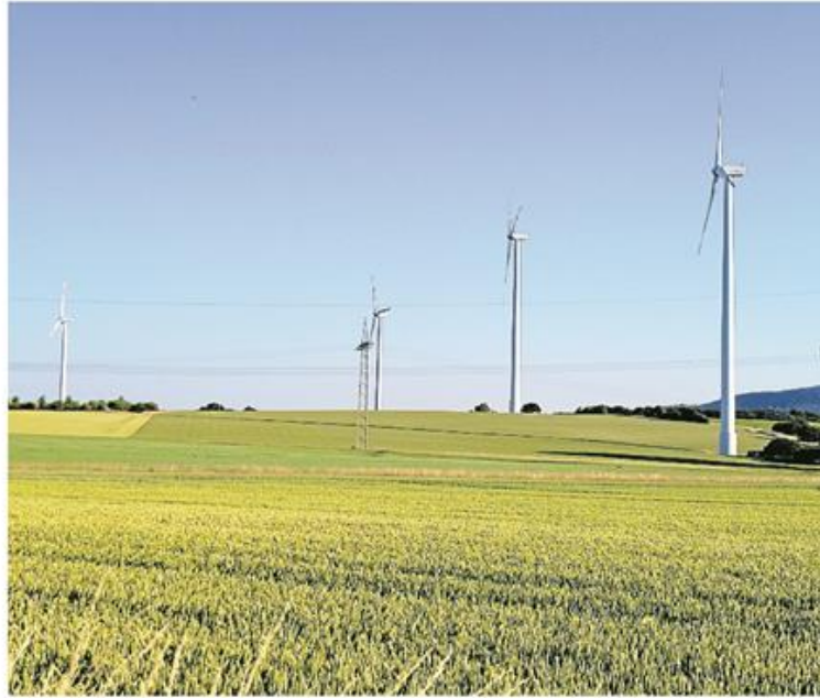
Diese vier älteren Windkraftanlagen auf dem Dörenberg sollen ersetzt und mit zusätzlichen drei Anlagen erweitert werden. FOTO: TI
